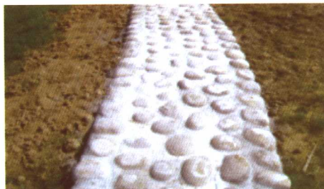
彩图 2-22 正在施工中的大块卵石园路
