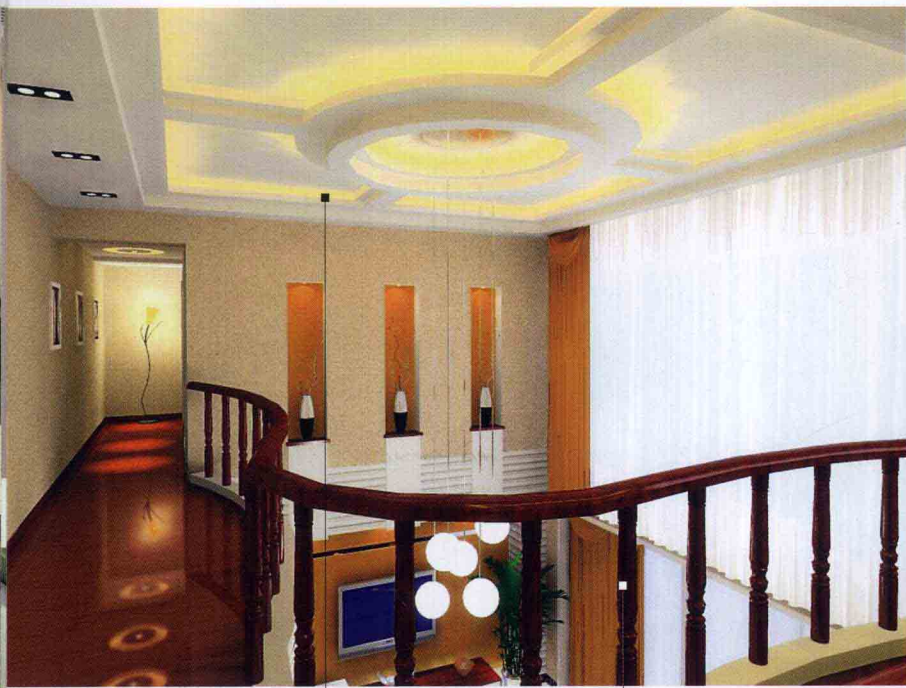
石膏板装饰吊顶
