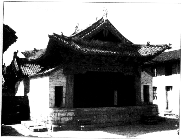
山西沁水县郭壁村府君庙元代戏台
