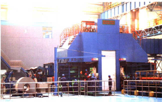
▲ 特钢第二台单机架冷轧投产，首钢冷轧至彩涂全线贯通。(摄影 蔡春来)
