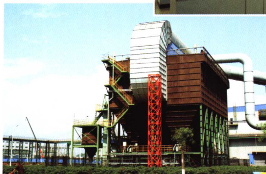
► 投资2.57亿元用于环保，高炉干法除尘消除了二次污染。(摄影 褚玉平)
