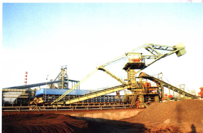
▲ 设备稳定运行，故障停机率为1.72‰。图为迁钢的料场设备。 (摄影 付建伟)
