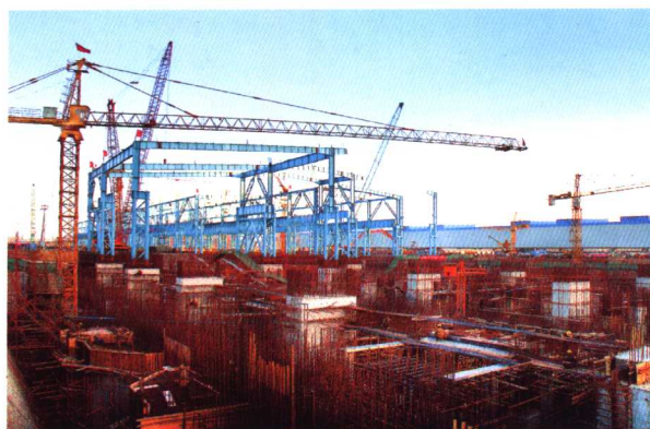
▲ 迁钢2160毫米热带轧机工程建设。(摄影 张华东)
