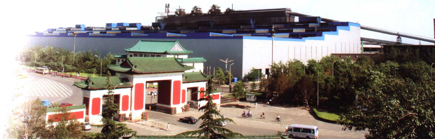
▼股份公司第二炼钢厂年产钢515.7万吨，双高比56%，形成了向板材、线材、棒材三条精品线供坯的能力。(摄影 褚玉平)
