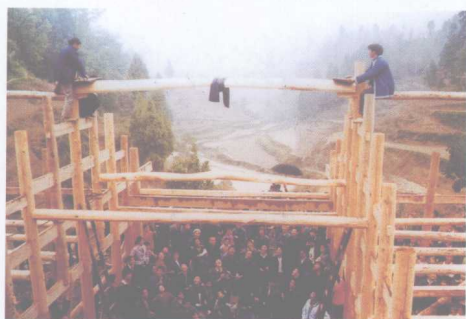
土家人建筑房屋，掌墨师向来宾抛撒梁粑
