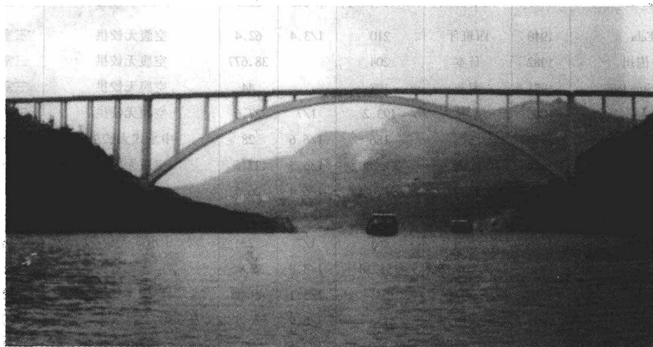
图 1-1-1 重庆万县长江公路大桥
