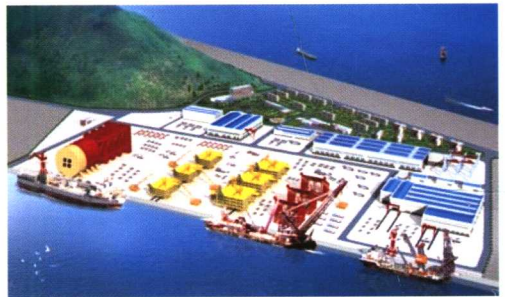
青岛海工建造基地
