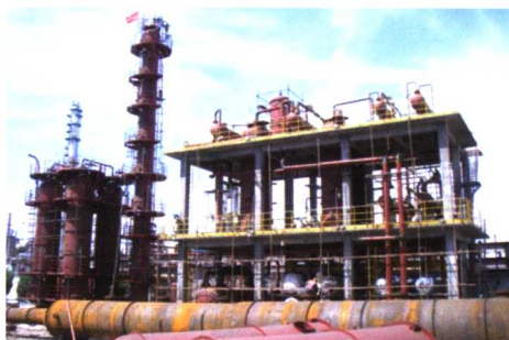
在建的乌鲁木齐石化100万吨/年 大芳烃装置
