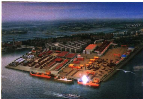
在建的渤海湾生产支持基地
