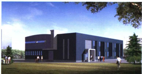
在建的中国石油海工重点实验室
