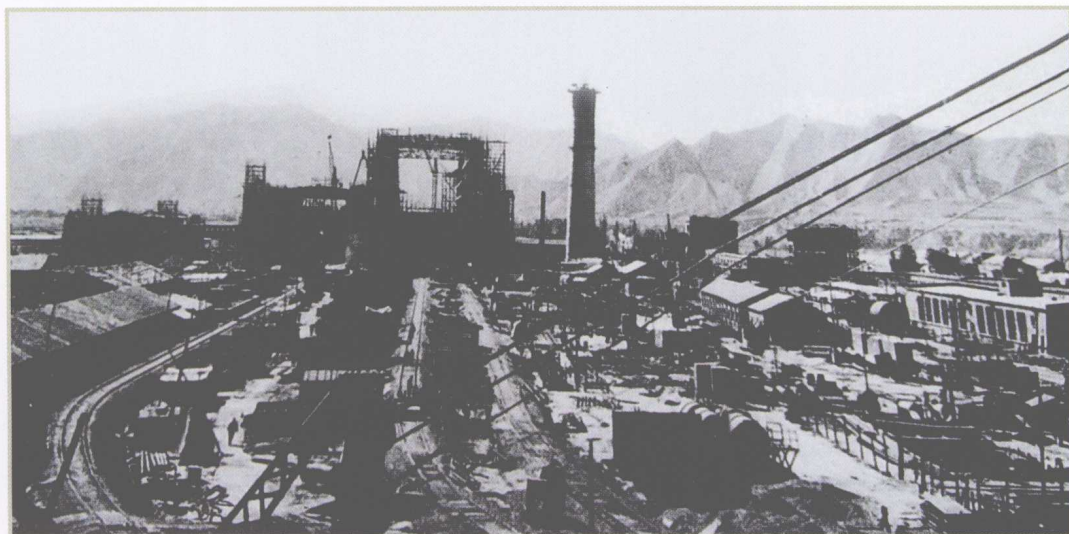
1957 年在建设中的西固热电厂施工工地
