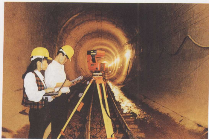
在广州市地铁杨一体区间隧道富水流沙地层首次采用“浅埋暗挖法”施工。荣获广州市科技进步一等奖。
