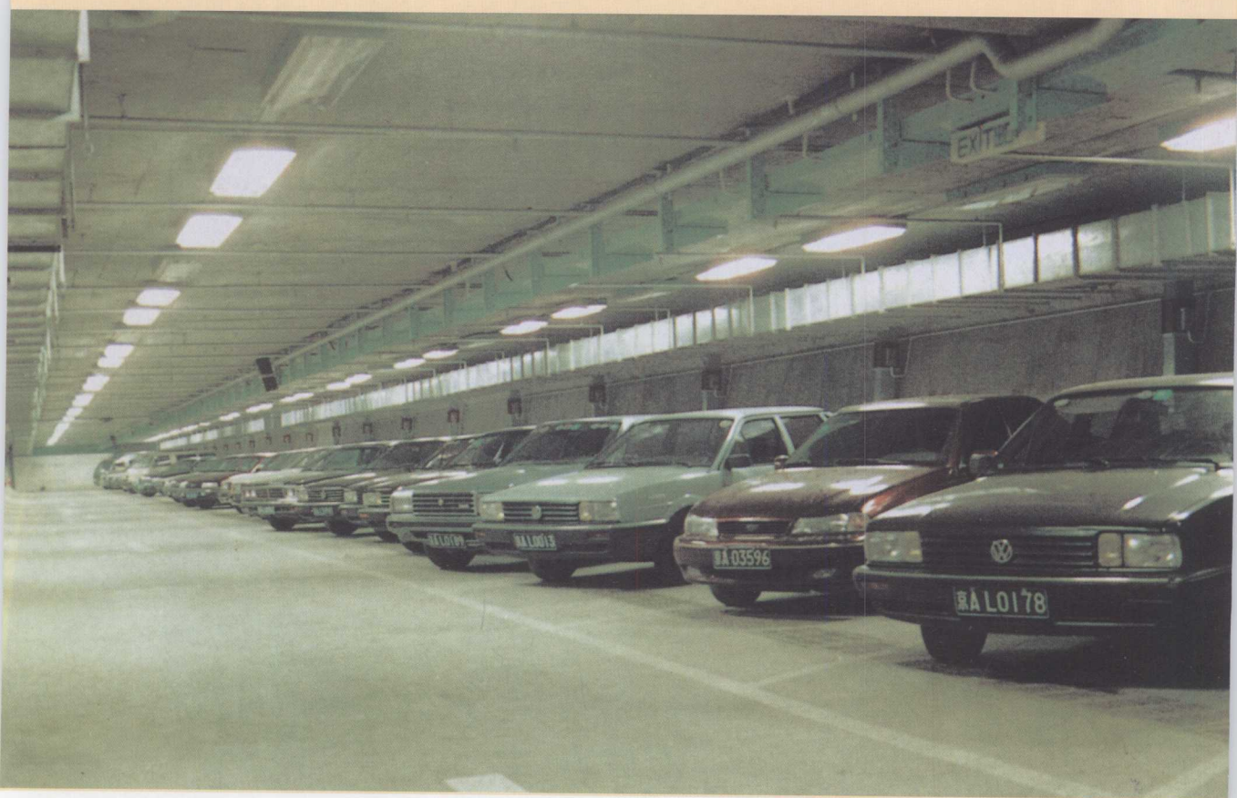
第一次采用“超浅埋CRD工法”修建的原国家计委地下停车场（双层）。荣获北京市科技进步二等奖。
