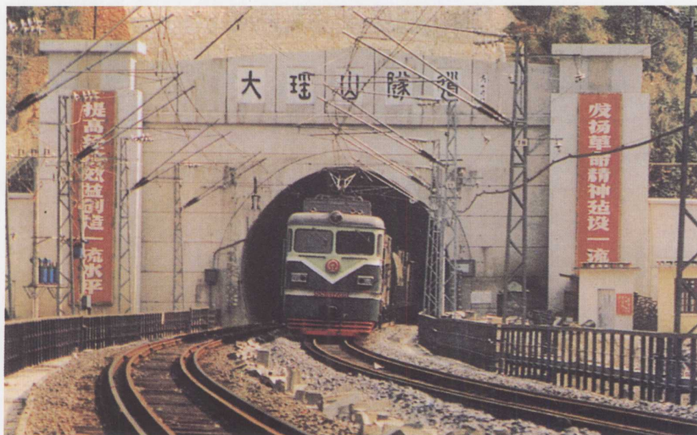
采用复合式衬砌结构、新奥法施工建造的中国最长大双线电气化铁路隧道——全长14 295m的大瑶山隧道。1981年开工，1987年建成。荣获国家科技进步特等奖。
