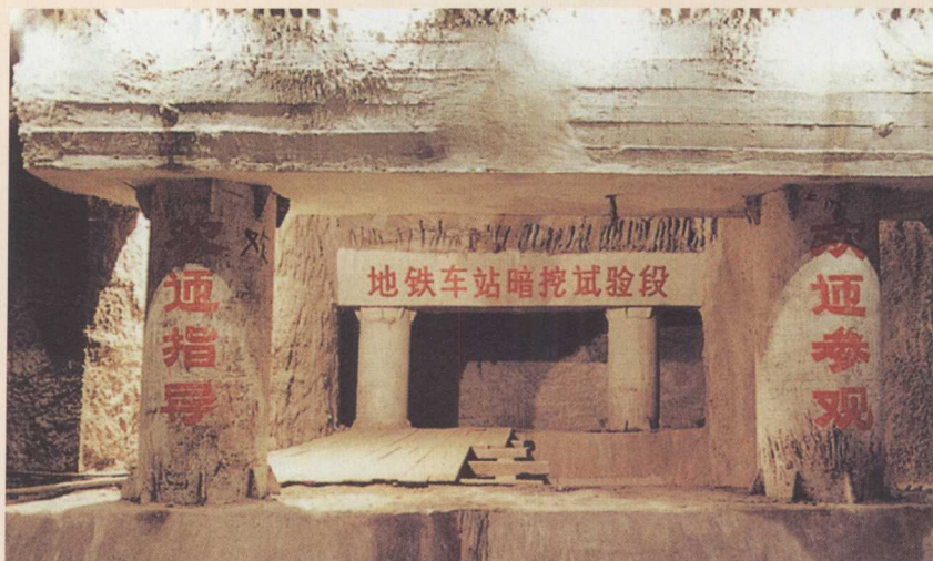
第一次采用“浅埋暗挖法”建成的城市地铁大跨车站试验段——北京市地铁站试验段。荣获北京市科技进步二等奖。
