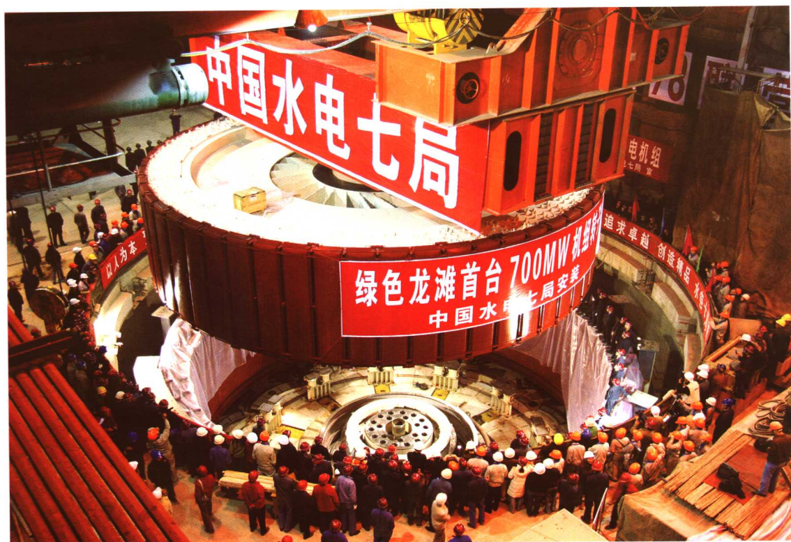
龙滩水电站世界首台 70 万 kW 空冷式水轮发电机组转子吊装成功
