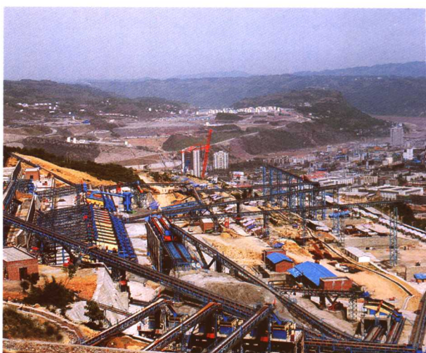
施工中的向家坝水电站马延坡及太平料厂砂石加工系统工程
