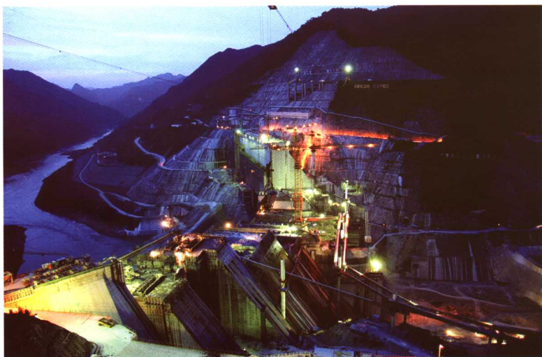
广西龙滩水电站大坝工程施工夜景
