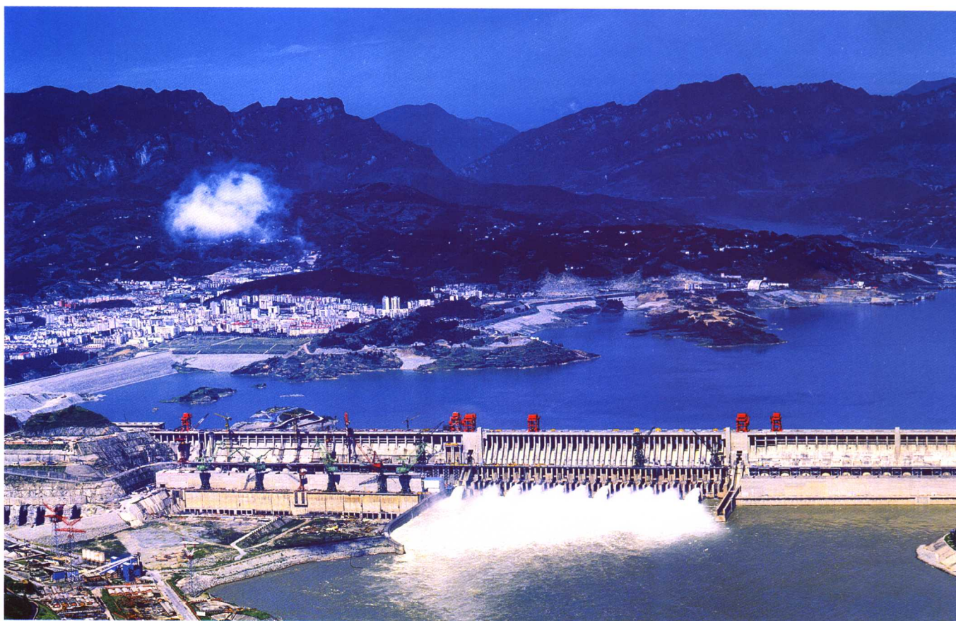
三峡大坝全景
