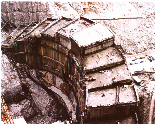
黄河拉西瓦水电站大坝工程施工全景
