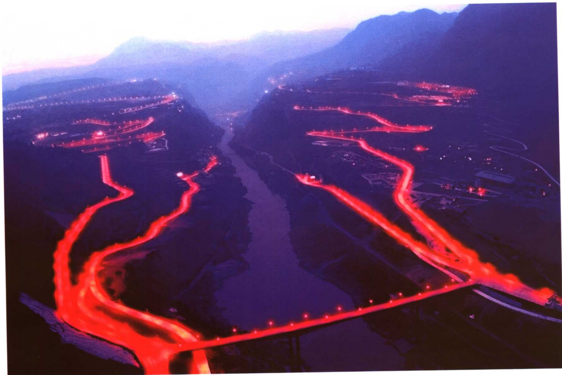
装机容量 1260 万 kW 的溪洛渡水电站正在加紧建设，图为流光溢彩的溪洛渡工地之夜
