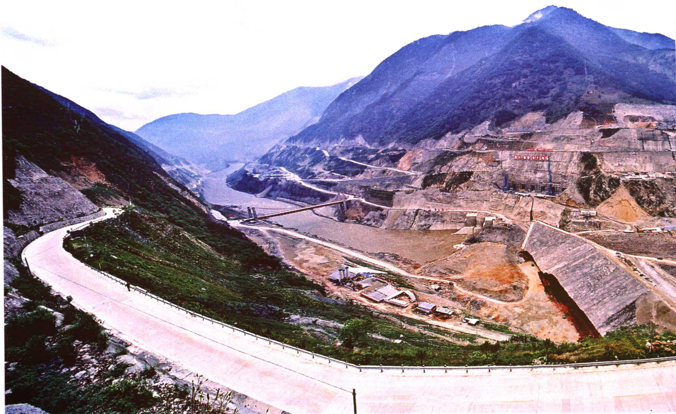
瀑布沟工地全貌鸟瞰
