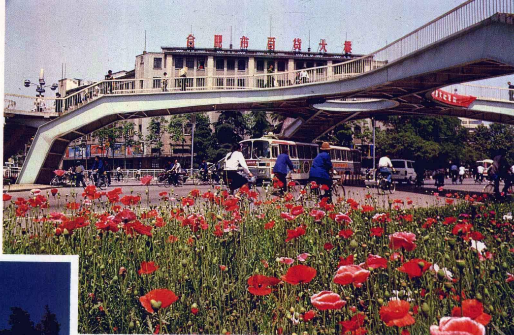
▲合肥范巷口人行天桥建成
