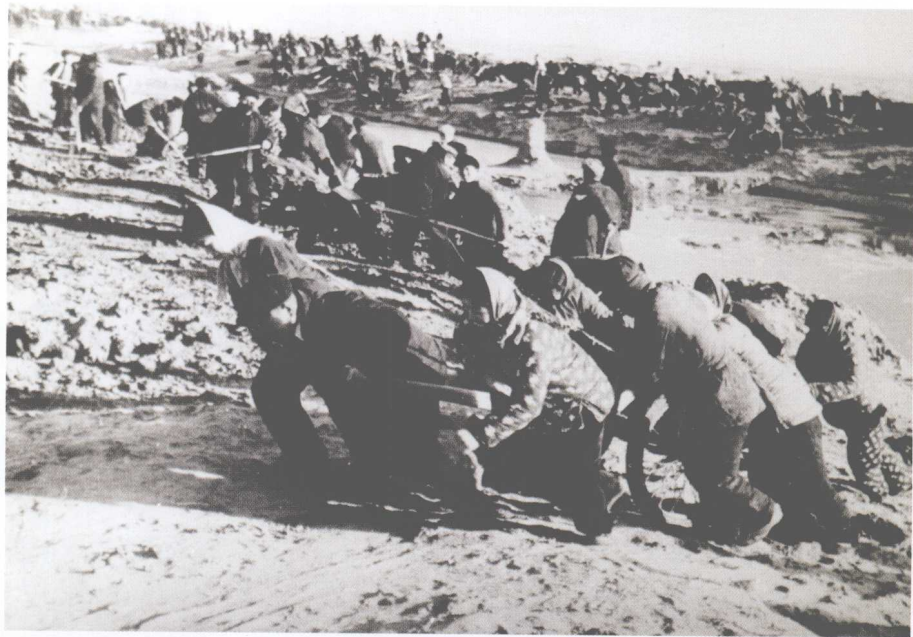
开挖沟河，治理水害
