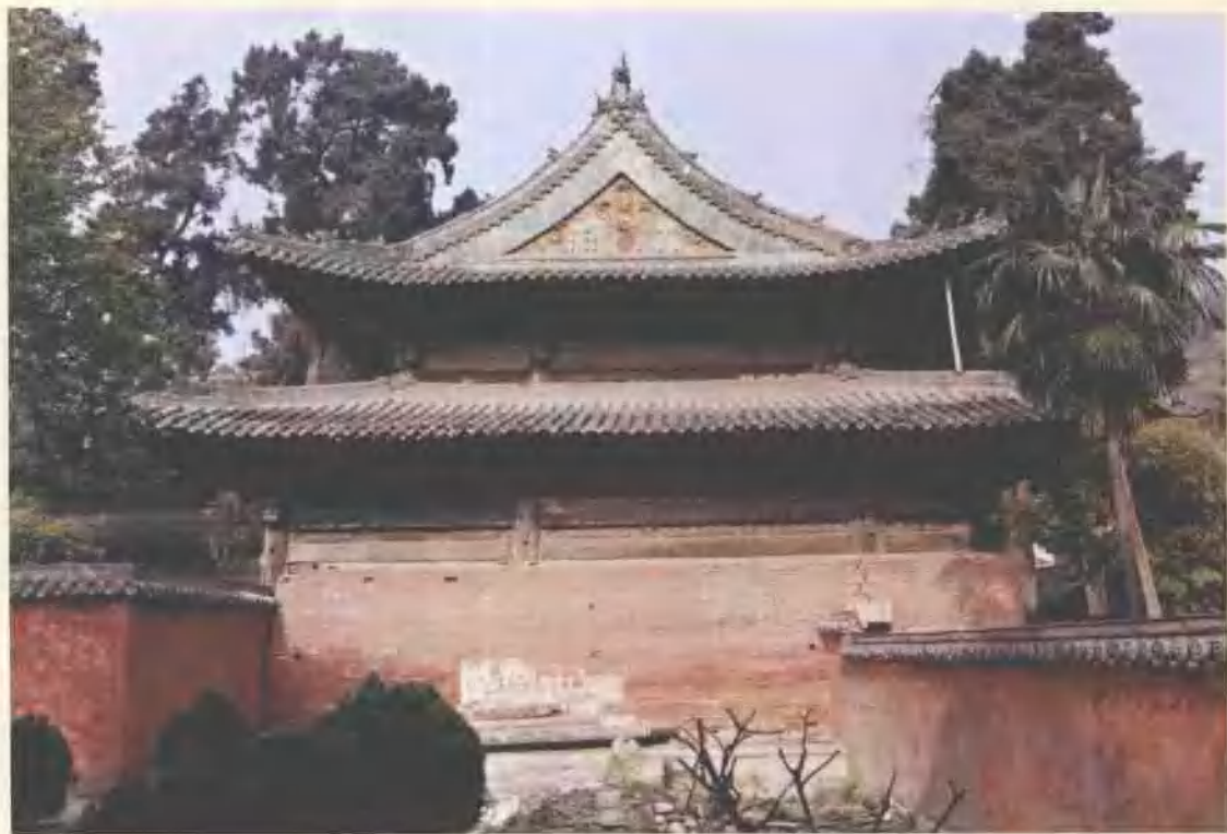
四川平武县报恩寺大悲殿侧立面
