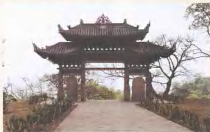
真武山玄祖殿牌楼
