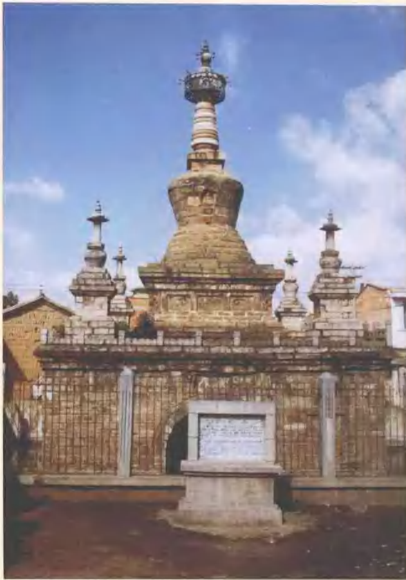
昆明市妙湛寺金刚塔正立面
