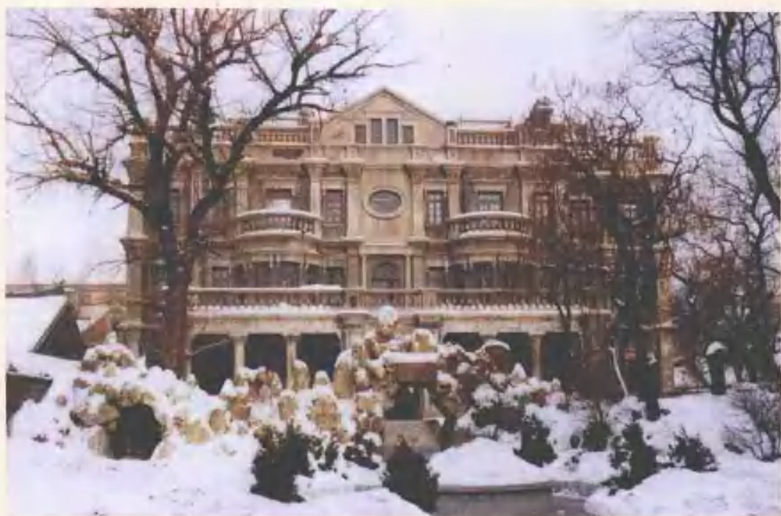
张学良旧居大青楼南立面
