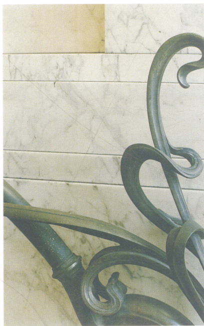
麦森·福里森的楼梯细部 维克多·霍塔，1894
