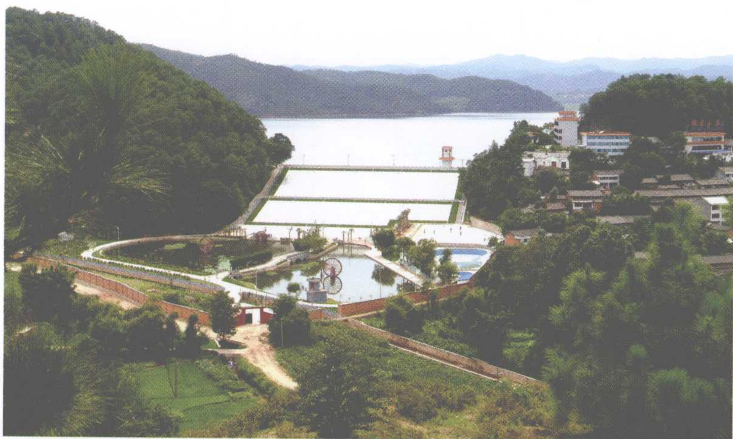
除险加固 后的毛板桥水 库新貌
