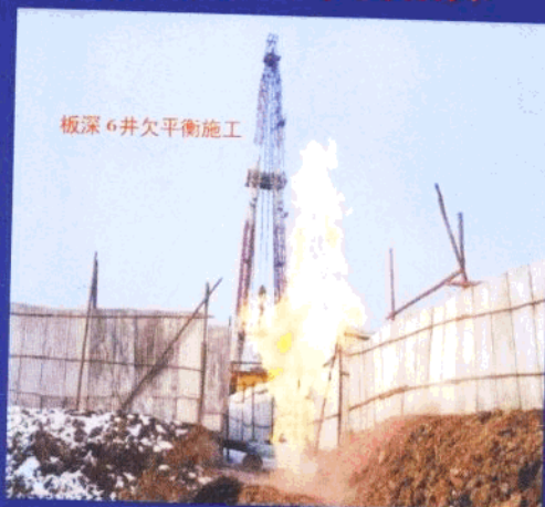
大港油田千米桥潜山板深6井欠平衡钻井现场
