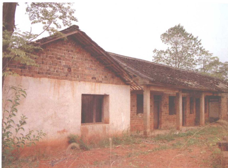
永州白芒营机场机组休息用房
