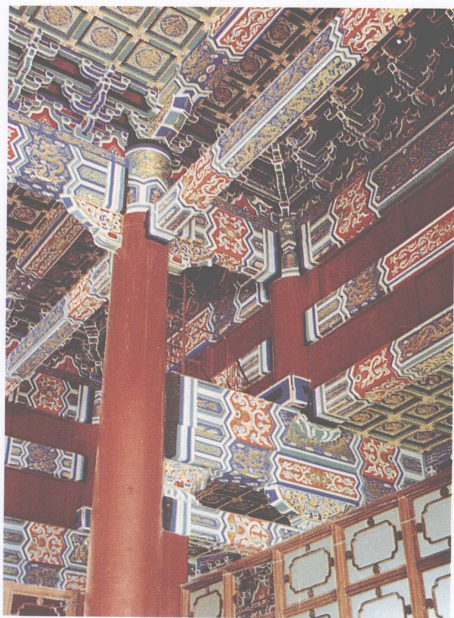
天安门城楼室内木构架局部
