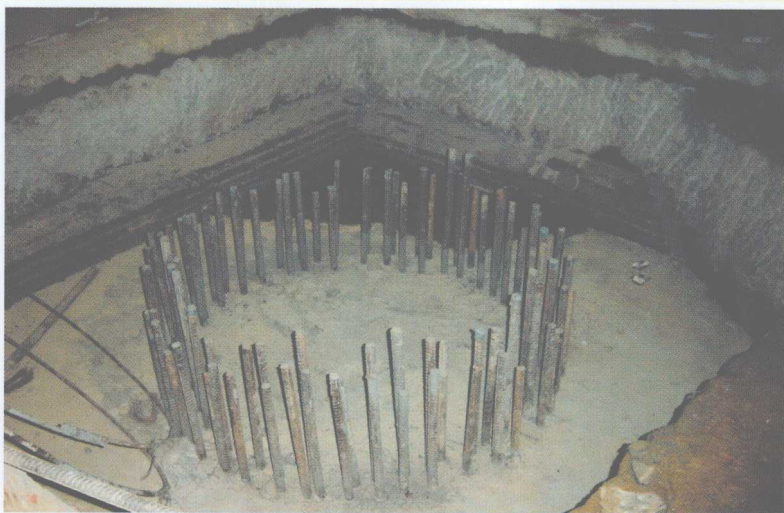
▲ 人工挖孔桩桩帽
