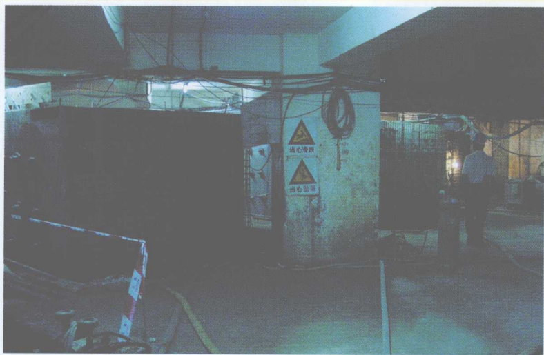
地下室负3层托换工程现场
