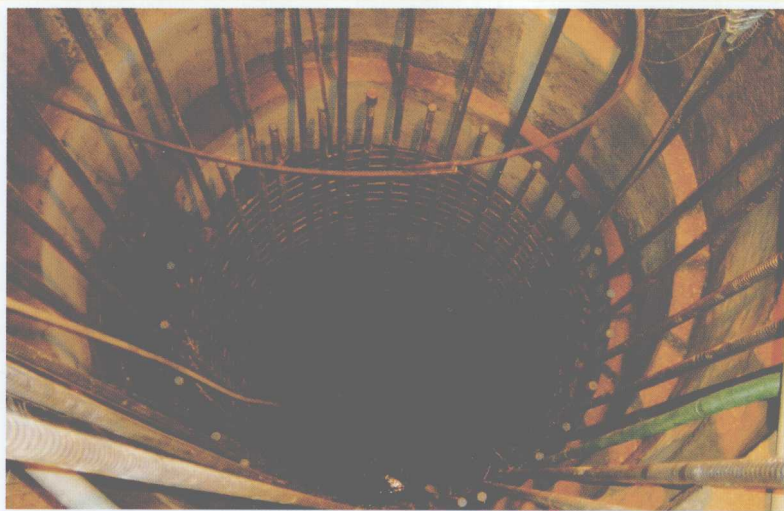
▲ 人工挖孔桩钢筋笼绑扎
