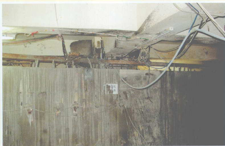
▶ 托换大梁与托换柱结合部
