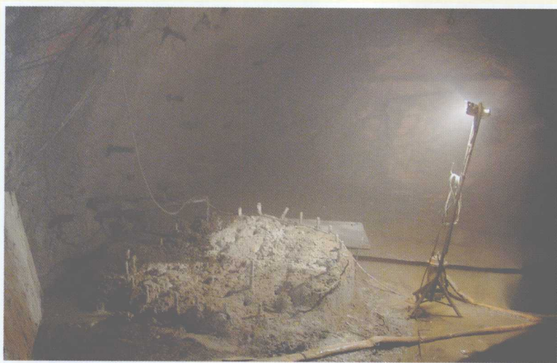
重叠隧道穿过截断的桩基
