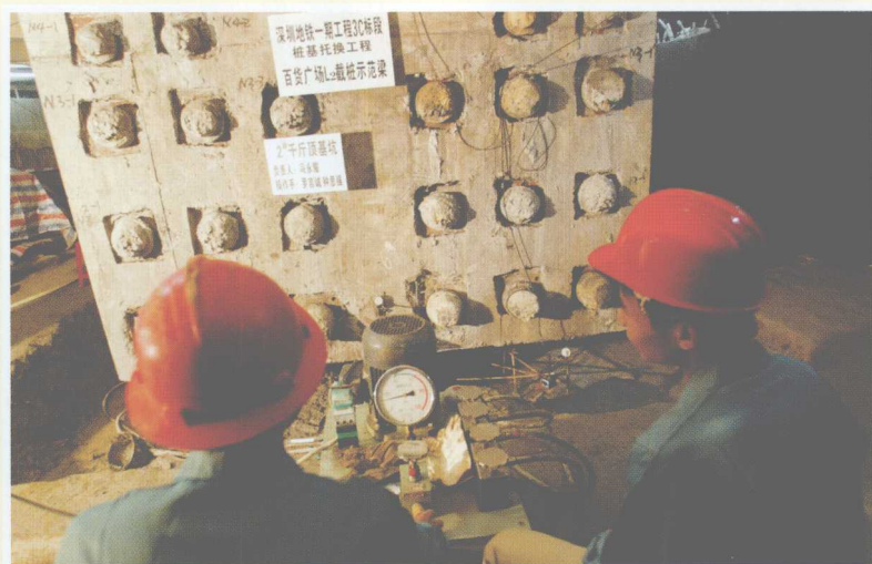
► 托换梁顶升加载试验
