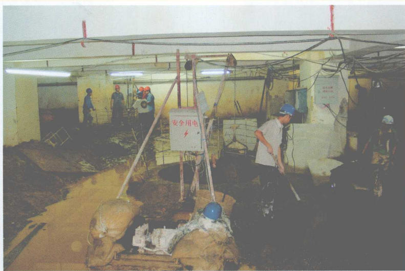
► 人工挖孔桩施工现场
