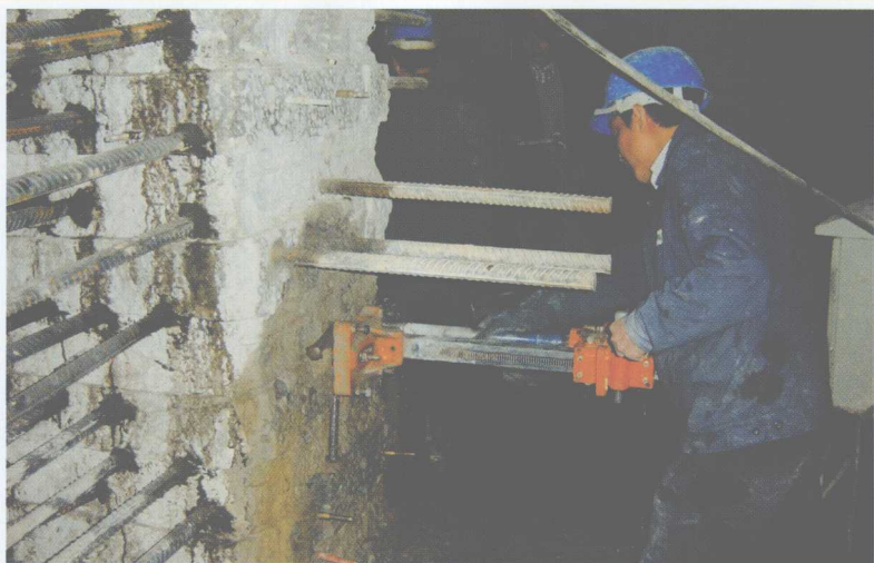
► 梁柱接头处理
