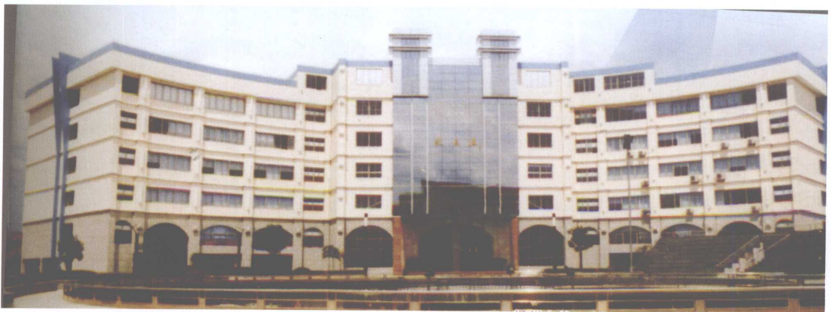
△ 嵊州第二中学综合楼
