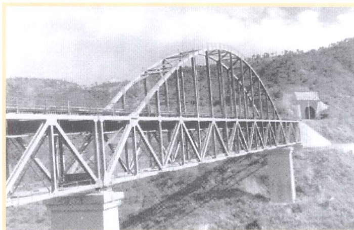
1965~1970年 在成昆铁路首次建设成功44座栓焊钢桥,在此基础上建成我国长江上最大铁路钢桥九江大桥及芜湖大桥
