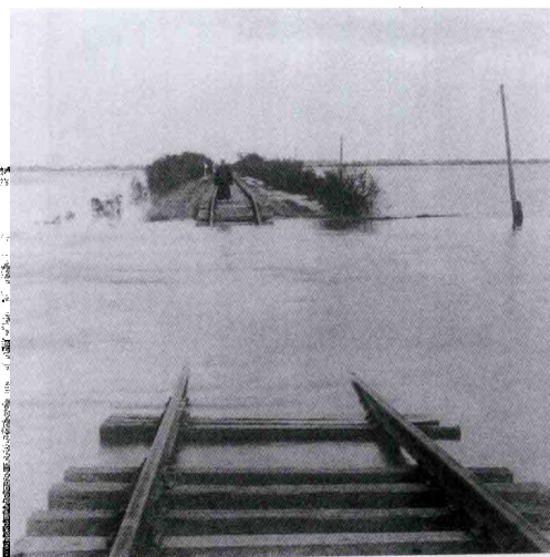
1917年为了利于泄洪，扒平了津浦路的路基
