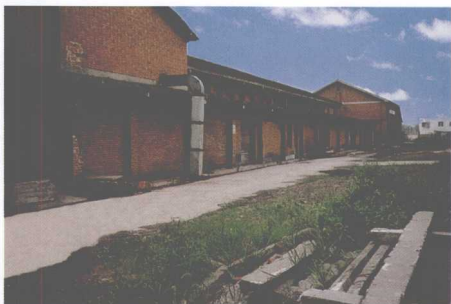
■ 1988年烟厂扩建前 的厂房外貌
