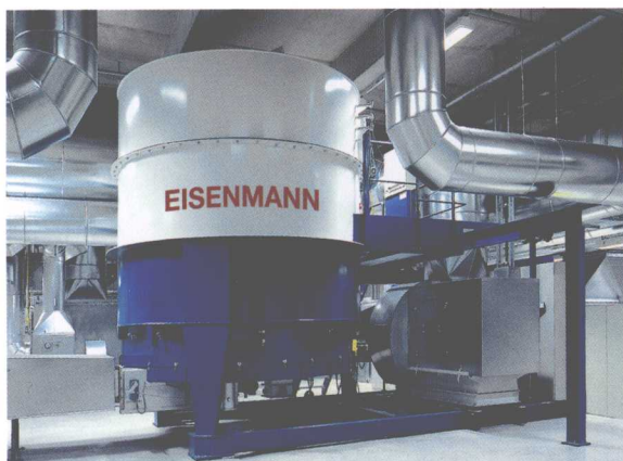
汽车零部件涂装用RTO废气处理装置
