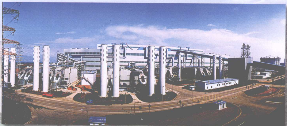
最先进的新炼钢除尘系统
