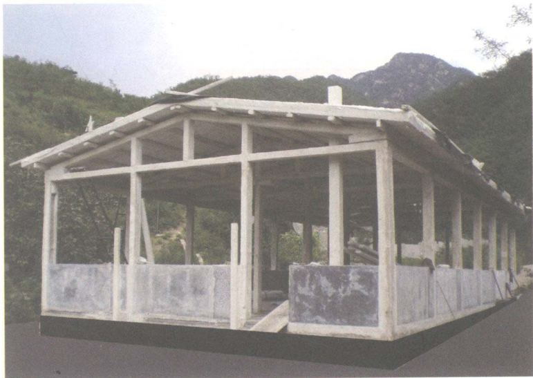
框架安装，未用吊装器械和铁件连接。安装时，几个男人肩扛手抬； 制造时，几个女人手工操作
