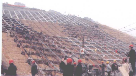
削坡整形施工
