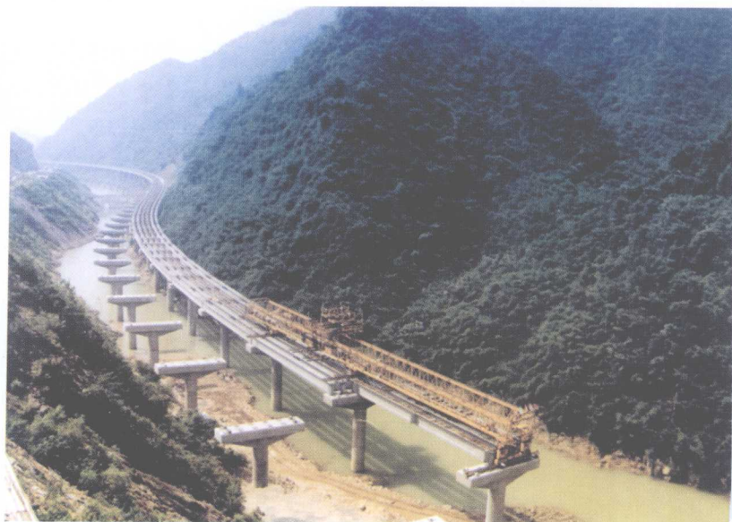
基建分公司正在架设的京珠高速公路粤北段最长的温泉双口河特大桥
