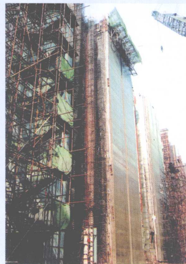
利用“单侧滑模”和“滑框导模”技术浇筑的混凝土薄壁衬砌墙非常坚固
