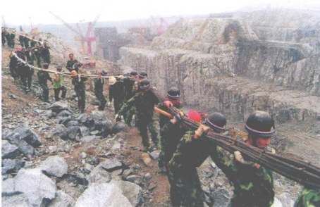
永久船闸高边坡锚固与稳定
