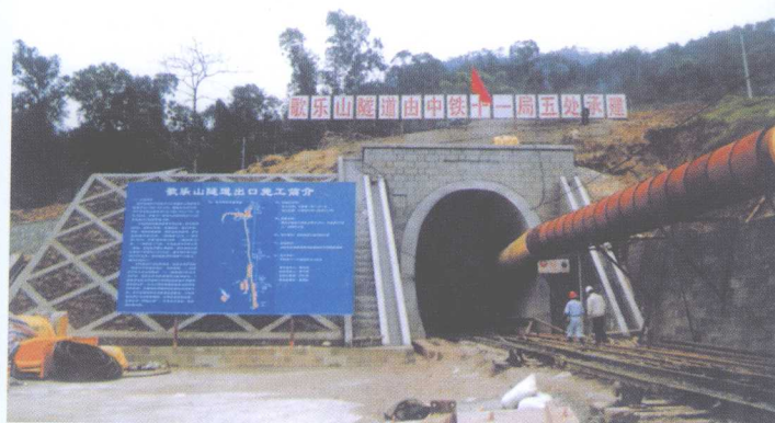
施工中的渝怀铁路歌乐山隧道
