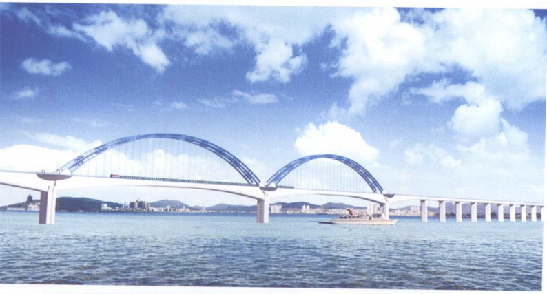
铁四院设计的宜昌长江大桥采用新颖和连续刚构柔性结构
