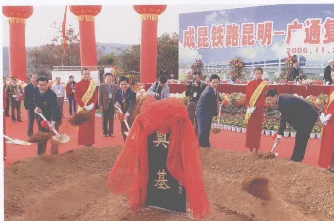
成昆铁路昆 明——广通复 线建设工程开工
