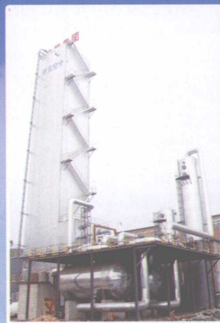
◆ 安装在四川达钢的 15000m 3 /h 空分设备
