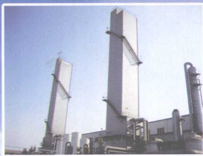
◆ 安装在江阴长强的 6500m 3 /h 空分设备
