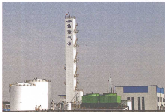
◆ 苏州 3000m³/h 液体空分设备全景
