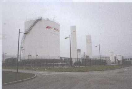
3000m 3 低温液体贮槽
