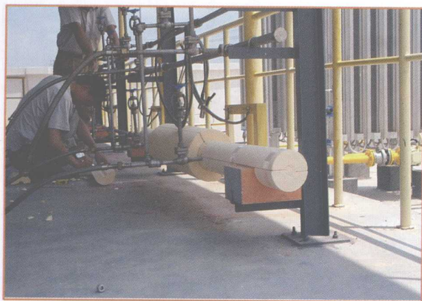
低温保冷管道施工
