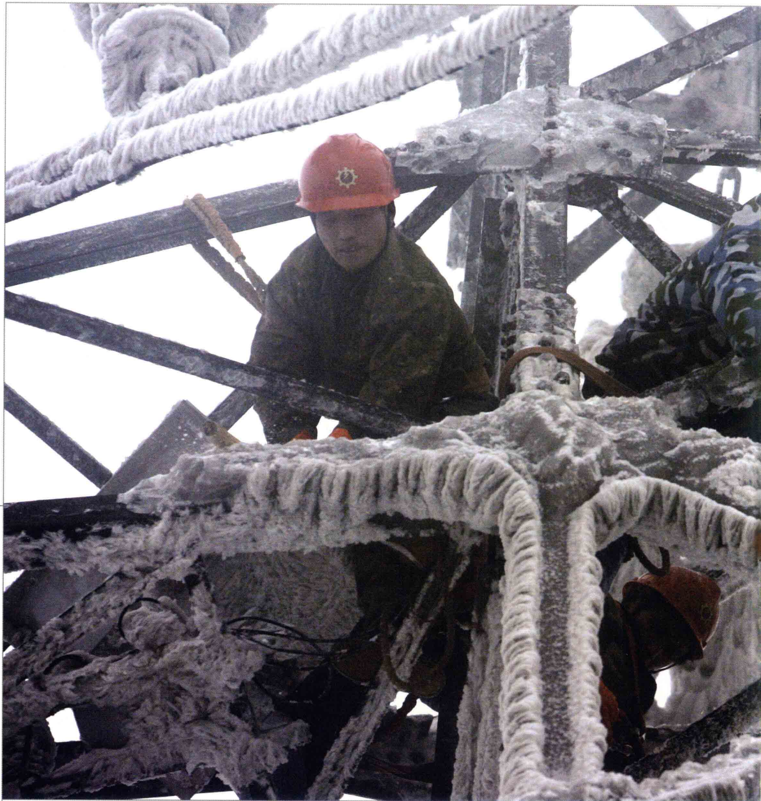
2008年2月1日，湖南省浏阳市蕉溪岭，电力抢险队的队员正在铁塔上去除冰块。
