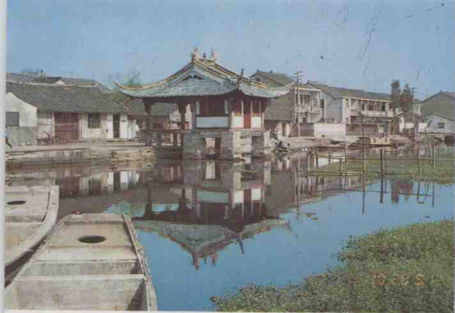
浙江绍兴县马山区安城河台
