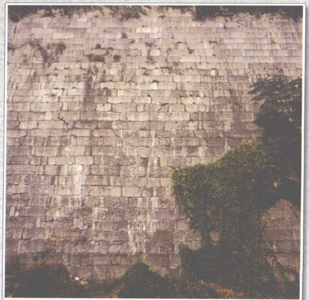
武定门段条石墙
