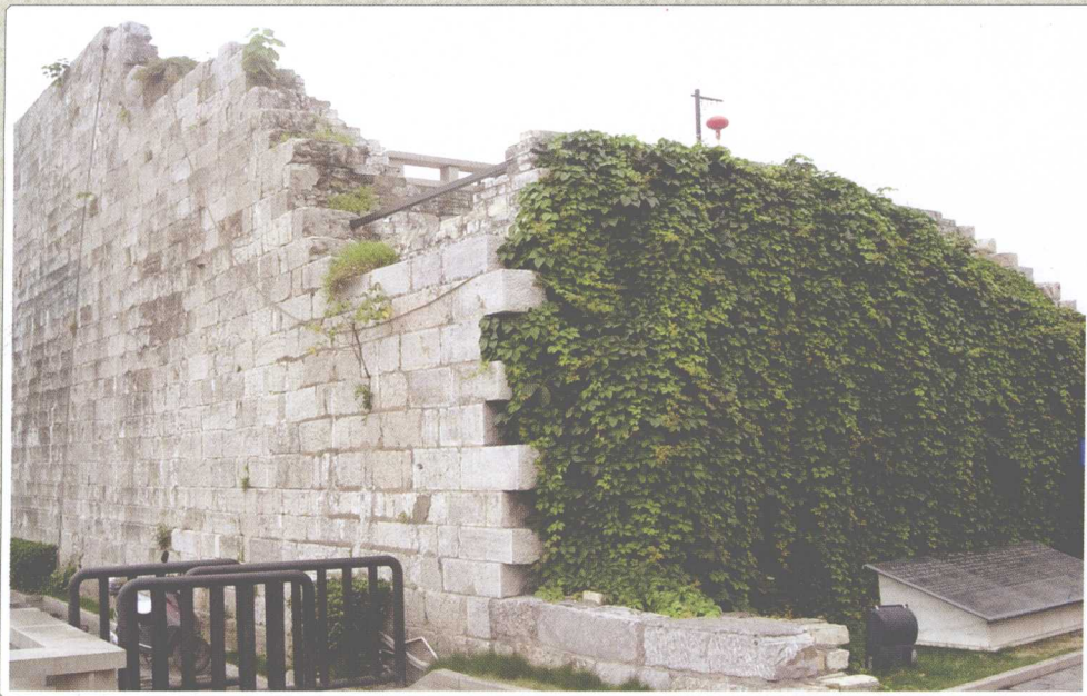
维修后的东水关城墙断面
