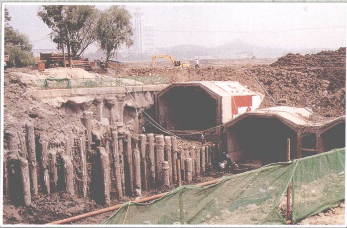
开挖玄武湖隧道中发现的城墙外侧止滑桩
