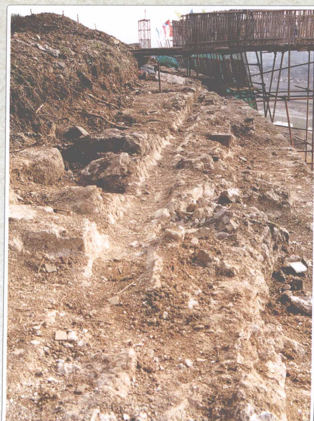
西千长巷段墙体内部排水暗沟
