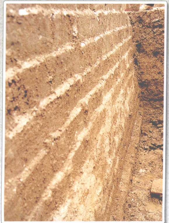
通济门段城墙底部勒脚
