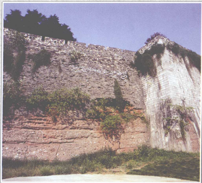
砖墙与条石墙接合部(清凉门段)
