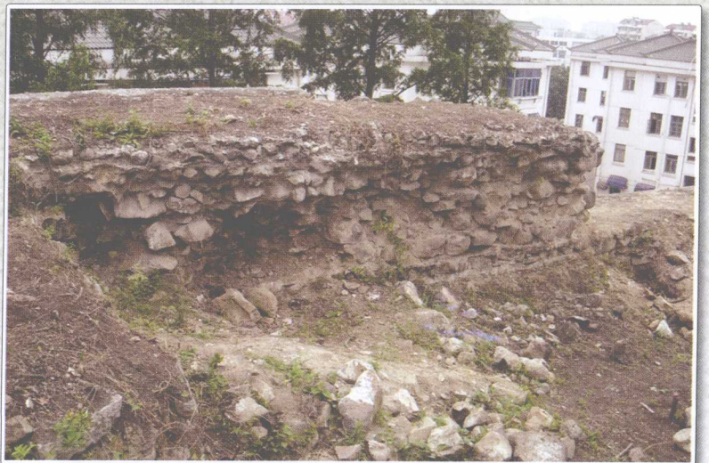
条石墙内部结构
