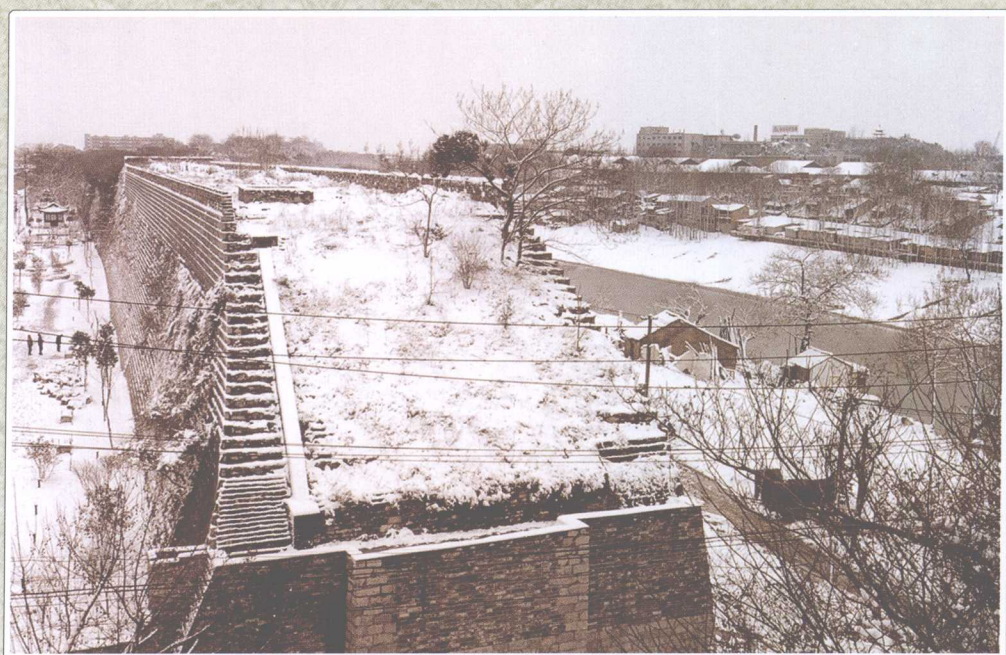
拆除中华东门留下的豁口
