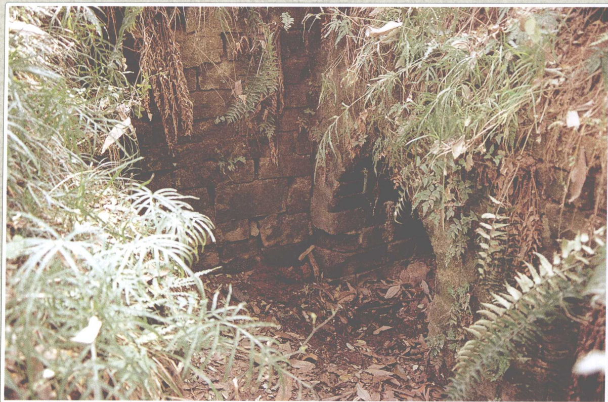
石头城段包山墙内侧汇水暗沟入口
