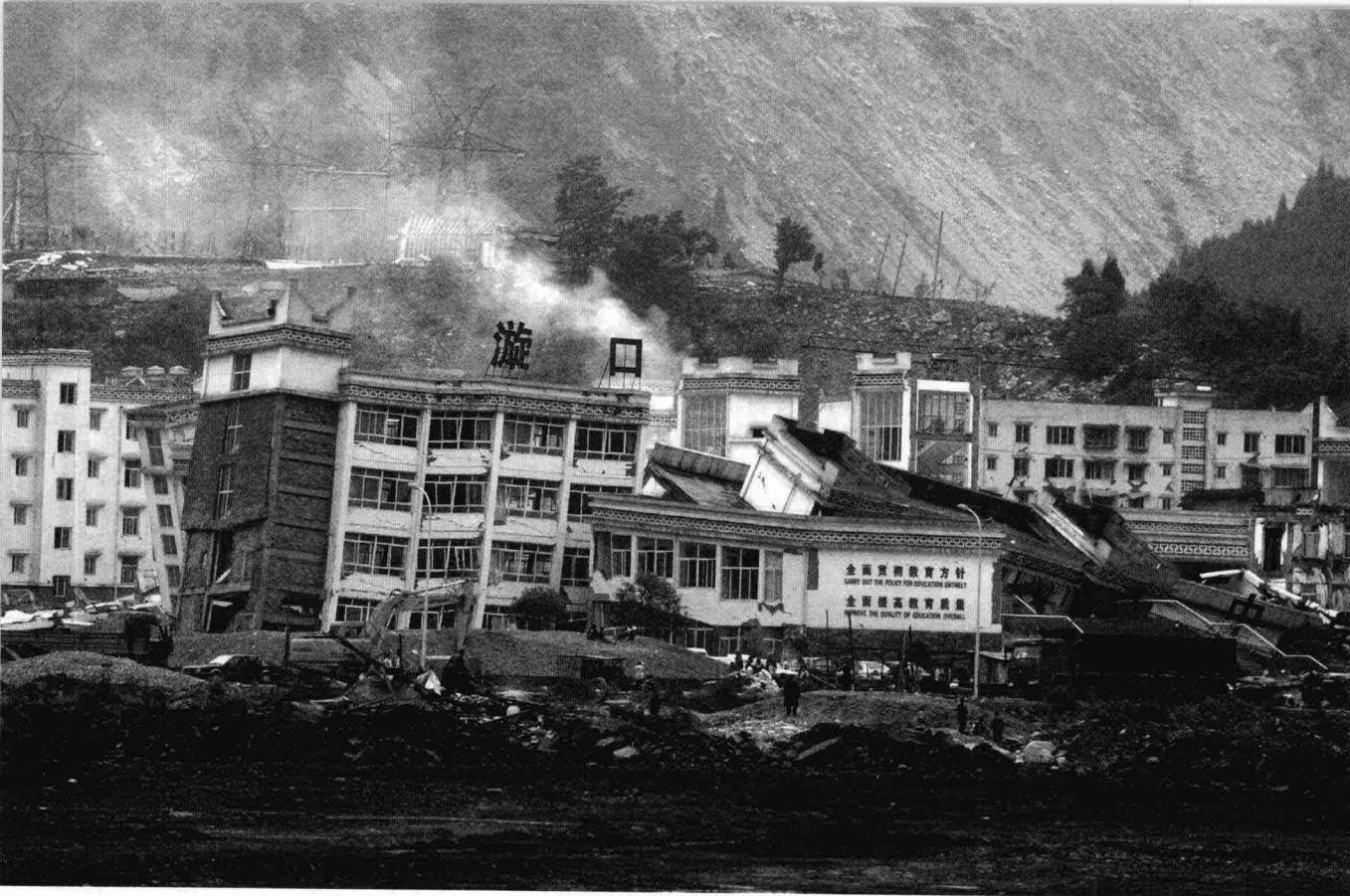
眼前就是遭到严重破坏的汶川县映秀镇漩口中学楼房。（新华社记者 陈树根 摄）
