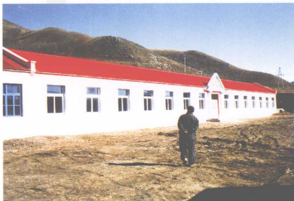
兴安盟阿尔山市五岔沟小学学生宿舍。
