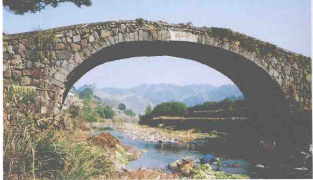
编志中发现的悬链线拱玉成桥（罗关洲摄）
