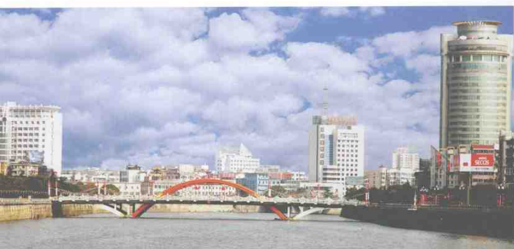
西施大桥 (应力刚摄)
