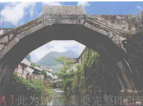
编志中发现的七折边拱万安桥（罗关洲摄）
