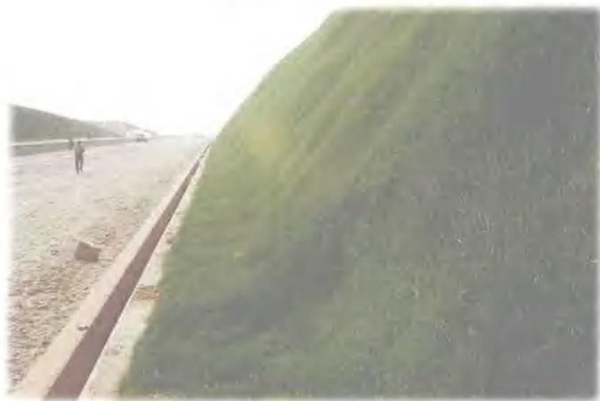
中铁十五局集团承建的 鱼嘴车站石方边坡绿色 防护
