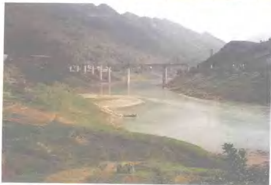
中铁十三局集团承建的 下塘口乌江双线特大桥 ——双薄壁高墩
