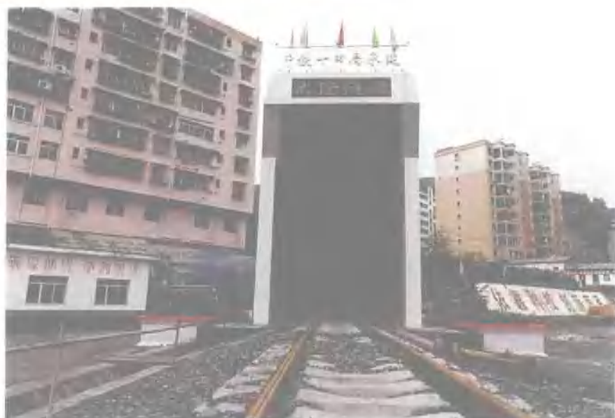
中铁十四局集团承建的 武隆隧道(长9418m,属 全线第二长隧道,图为 出口穿越居民密集区, 洞门设有环境保护的防 噪声隔墙)
