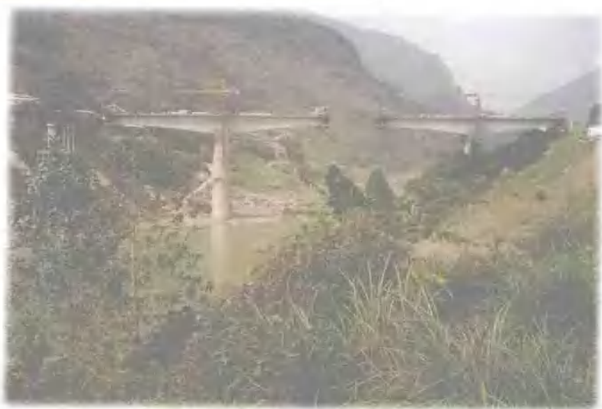
中铁十三局集团承建的 黄草乌江双线大桥—— 主跨168 m
