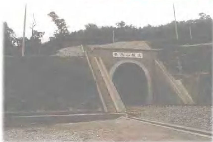
中铁十一局集团承建的 歌乐山隧道
