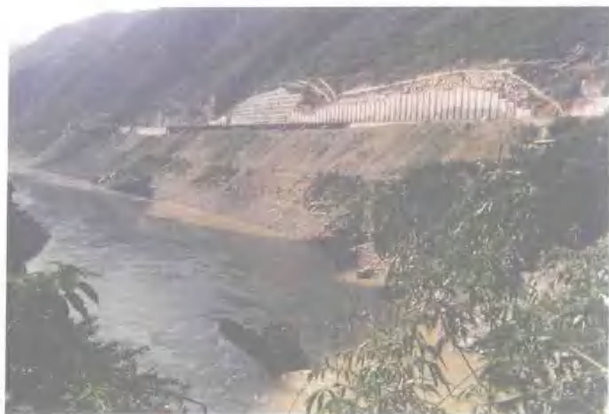
中铁二十局集团承建的 十一标段(桥隧比重占 98%，偶遇路基，亦挡 护相连)
