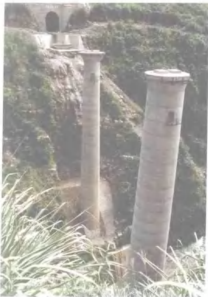
中铁十七局集团承建的位于悬崖陡壁上、桥隧相连的枫香堡中桥
