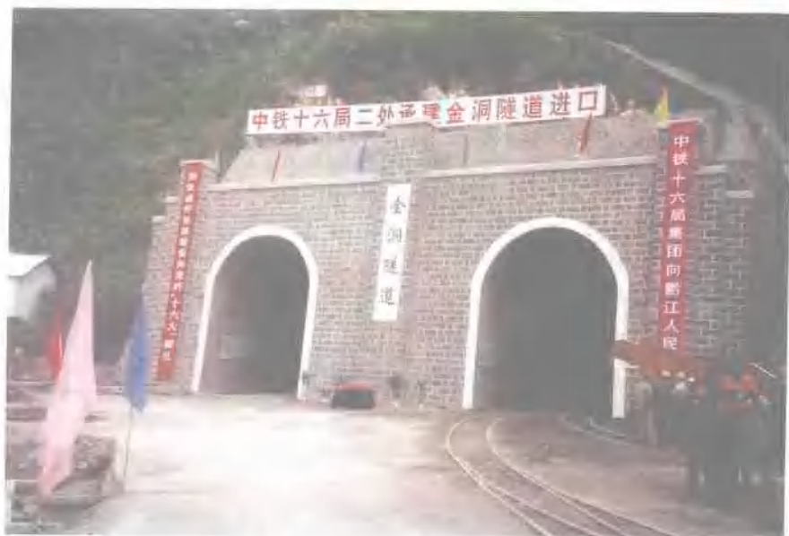
中铁十六局集团承建的 金洞隧道(长9108 m, 图 为进口施工场景, 左为 正洞, 右为平导)
