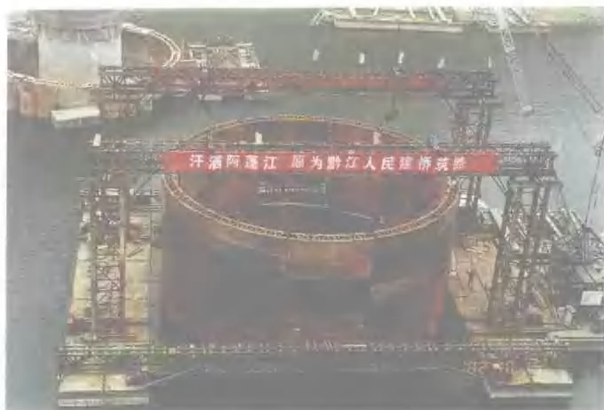
中铁十五局集团承建的 阿蓬江大桥水中墩正在 施工双壁钢围堰
