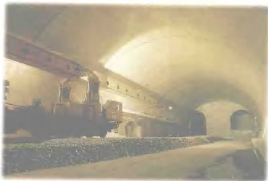
洞内铺轨作业
