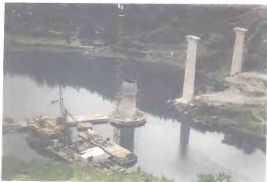
中铁十二局集团承建的 梅江1号大桥水中墩施 工场景
