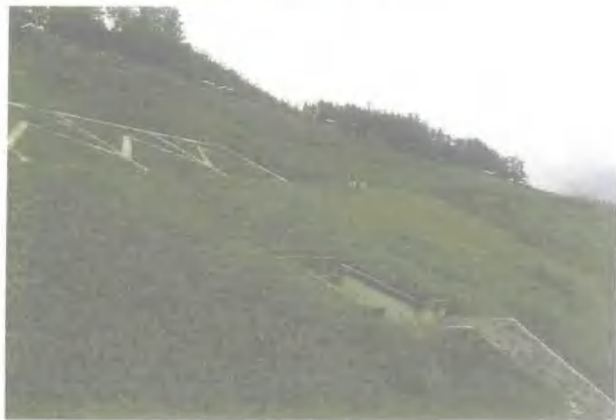
中铁十九局集团承建的 高谷车站边坡绿化防护
