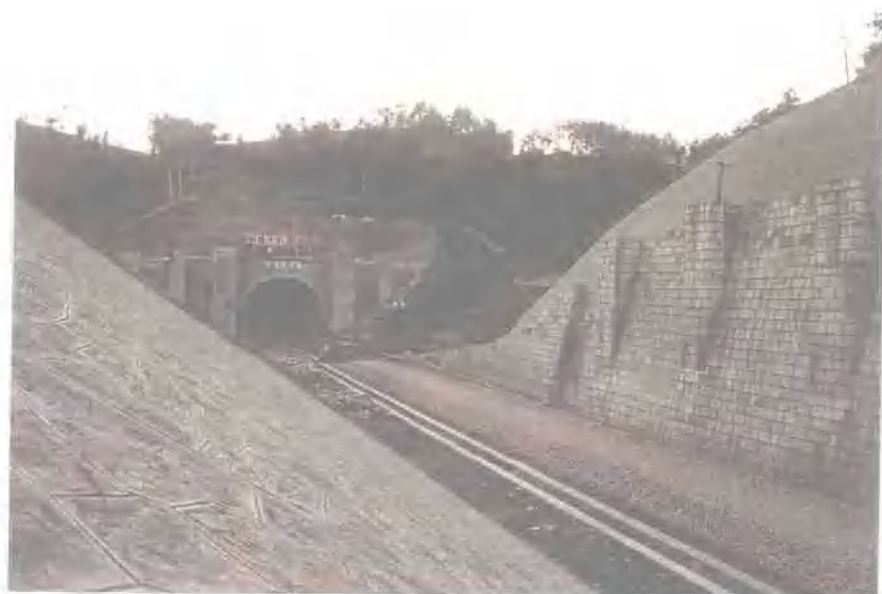
中铁十八局集团承建的 彭水隧道(长9028 m, 图 为位于滑坡体上的出口 双线洞门)
