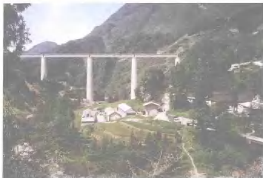
细砂河大桥用造桥机制 造的64 m箱形简支梁
