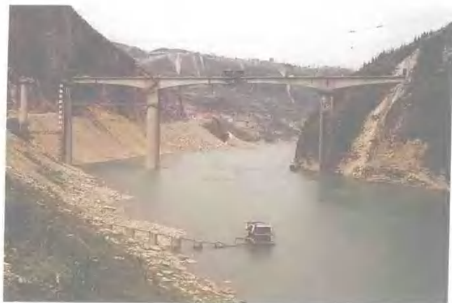
中铁十三局集团承建的 涪陵乌江大桥——桥隧 相连
