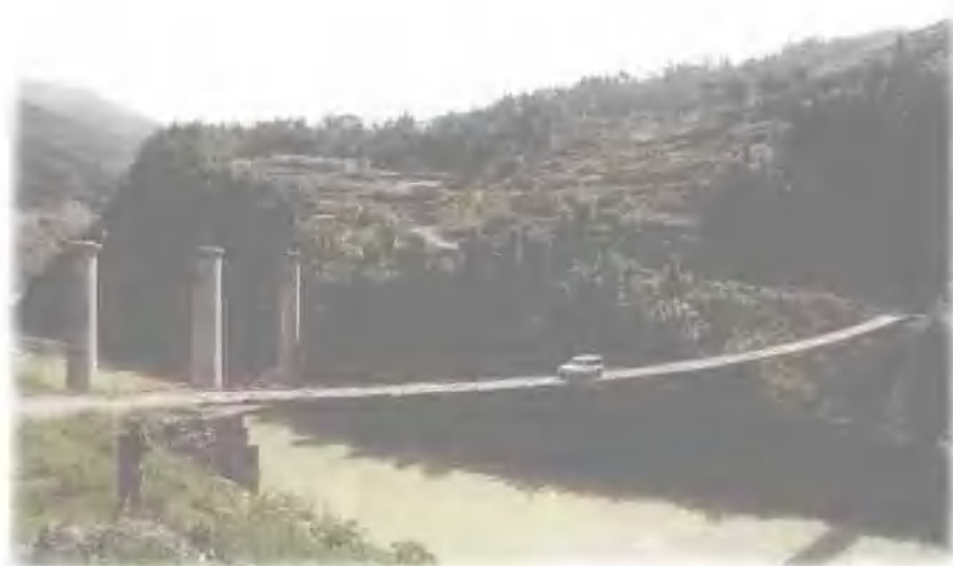
中铁十八局集团施工的 郁江公路悬索便桥
