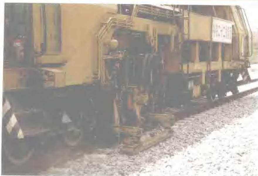
大型机械正在中铁十七 局集团施工的涪陵车站 作业
