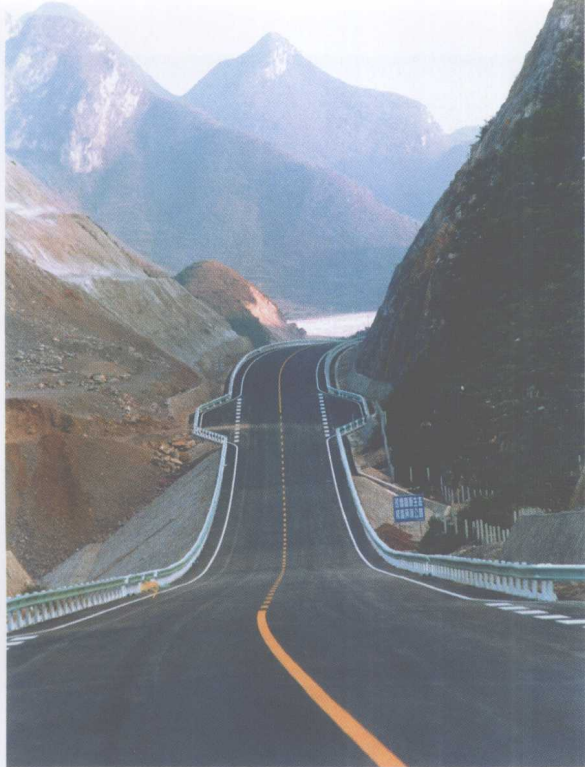
关(岭)兴(仁)公路 (肖建国 摄)
