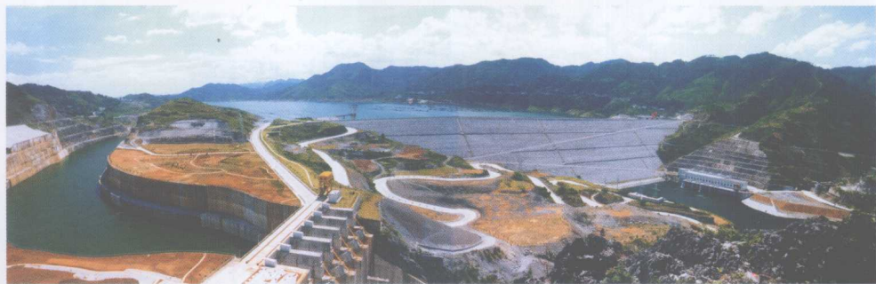
天生桥一级电站大坝（肖建国 摄）
