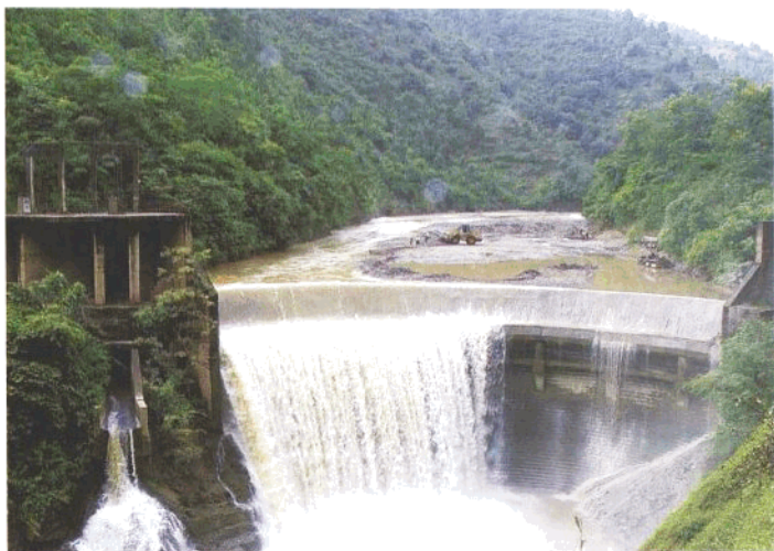
李仙江支流水土流失造成水库淤积
