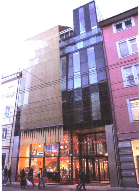
图1-14 奥地利茵斯布鲁克街上新旧建筑共同存在
