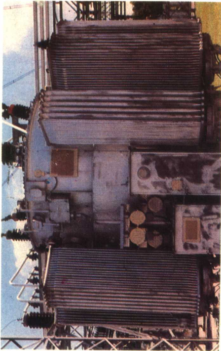
图8.8 设计的保护涂料。生锈变压器在喷砂清理之前进行可靠的预处理和涂底漆（在带电涂漆之前）。
