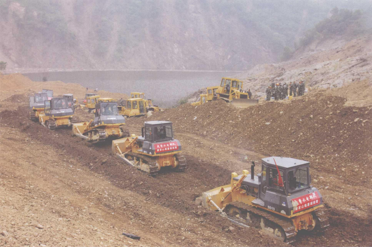
大型机械在唐家山堰塞湖抢险现场进行泄流槽施工
