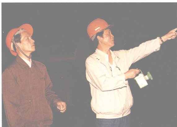
设计人员查看地下洞室开挖情况
