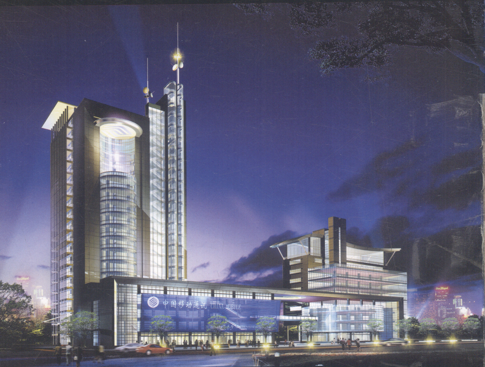
重庆大学建筑设计研究院 ● 中国移动通信成都枢纽楼 ● 许剑峰
