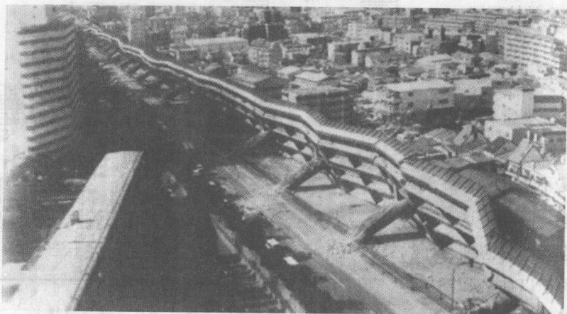
地震中高架桥应声而倒，梁柱折断，将马路隔绝。
