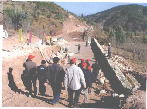
关巍公路升级改造山区段施工现场
