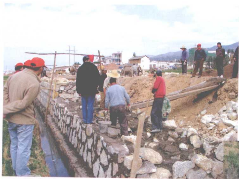
关巍公路升级改造坝区段施工现场
