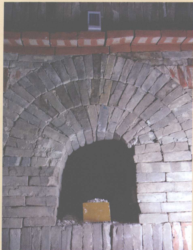
图 23 保护措施 图中上方为干湿度计,下方耳室中央为干燥剂。
