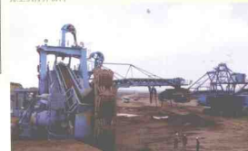
轮斗挖掘机剥离土层
