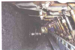
全煤厚综采支护
