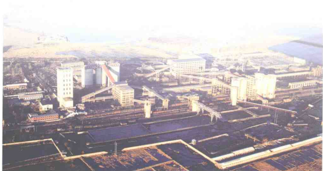
现代化矿井建设全貌
