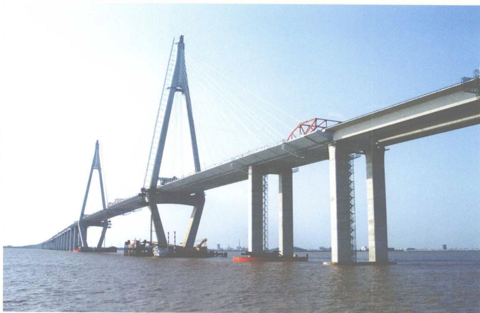
杭州湾跨海大桥北航道桥
