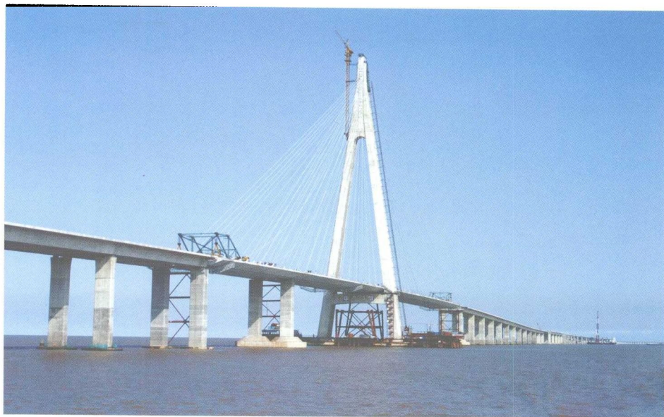
杭州湾跨海大桥南航道桥
