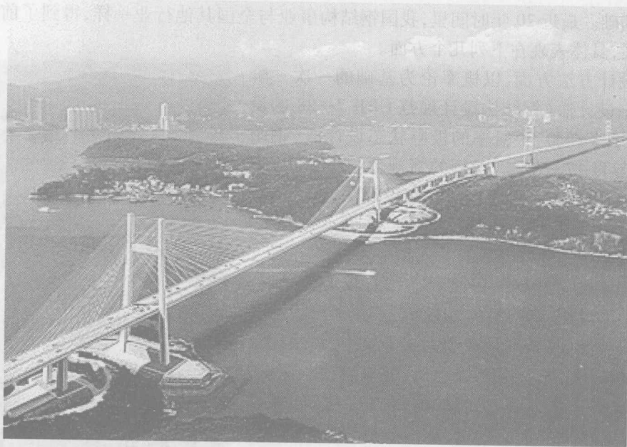
图 1.4 斜拉桥和悬索桥
