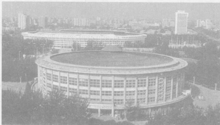
图 1.1 北京工人体育馆(悬索结构)
