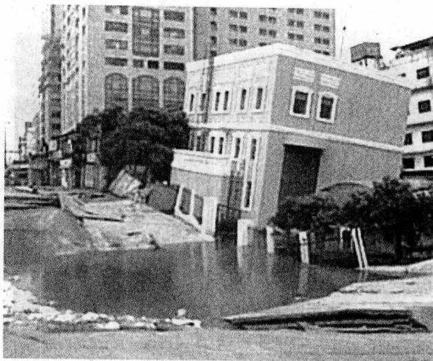
图 1-4 地面塌陷、建筑物倾斜
