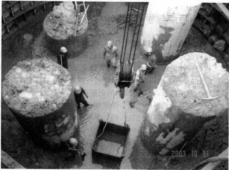
图 1-8 桥墩大直径桩基施工
